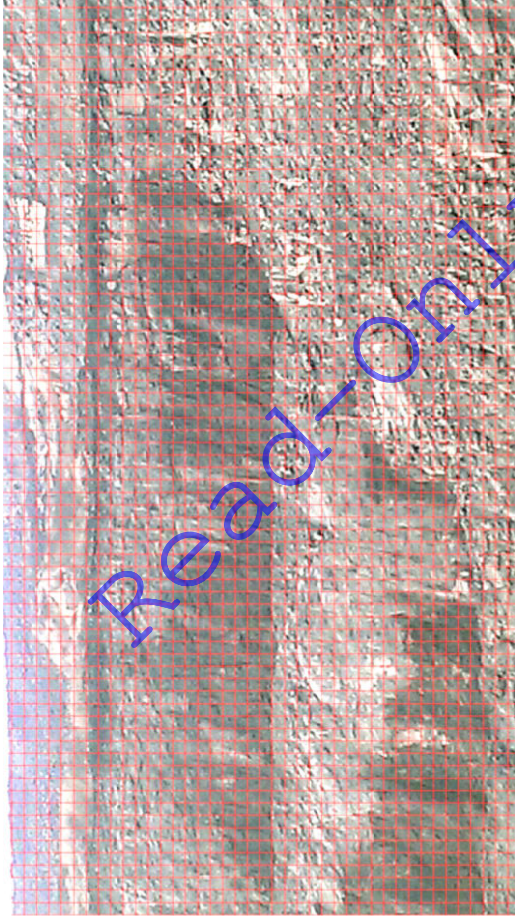
Рисунок 1.1 – г. Подвоєні уступи на південно-західного борту Ігулецького кар'єру, які виставлені в граничне положення методом контурного підривання ( \delta = 1 ).
