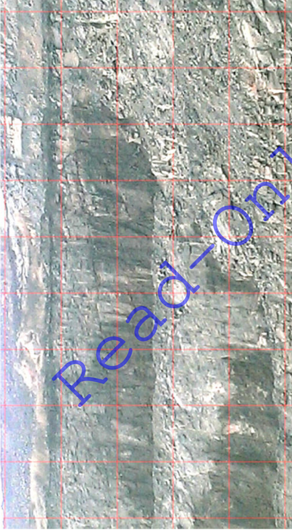
Рисунок 1.1. – а. Подвоєні уступи на південно-західного борту Інгулецького кар'єру, які виставлені в граничне положення методом контурного підривання ( \delta = 8 ).
