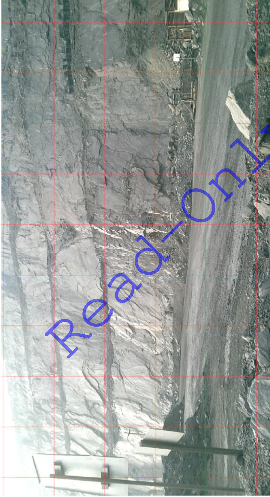
Рисунок 1.3. – а. Подвоєні уступи західного борту Інгулецького кар'єру, які виставлені в граничне положення по напластуванню ( \delta = 8 ).
