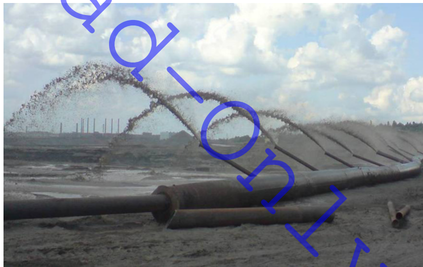
Рисунок 1 – Напірний метод складування відходів збагачення на ЦГЗК
